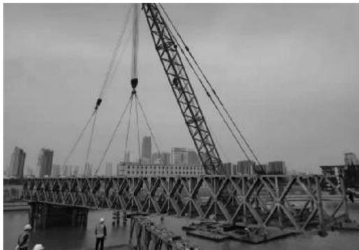
双排双层带第三弦杆结构,单跨桥长 54.864 米,桥面通行宽度 7.4 米,荷载双车道城市-B 级;人行钢便桥通航孔段采用的是 HD200 型双排单层,中间两节高抗弯、两端两节高抗剪结构,单跨桥长 48.768 米,桥面通行宽度 4.2 米,荷载人群 3.5KN/m<sup>2</sup>。经现场查看,发现航道上过往船舶较多,封航时间短,严重影响施工。为此,项目部多次优化施工方案,精心组织严控流程,最终吊装过程整体结构平稳,所有构件的任何部位未发生变形损伤,完全可以再次架
