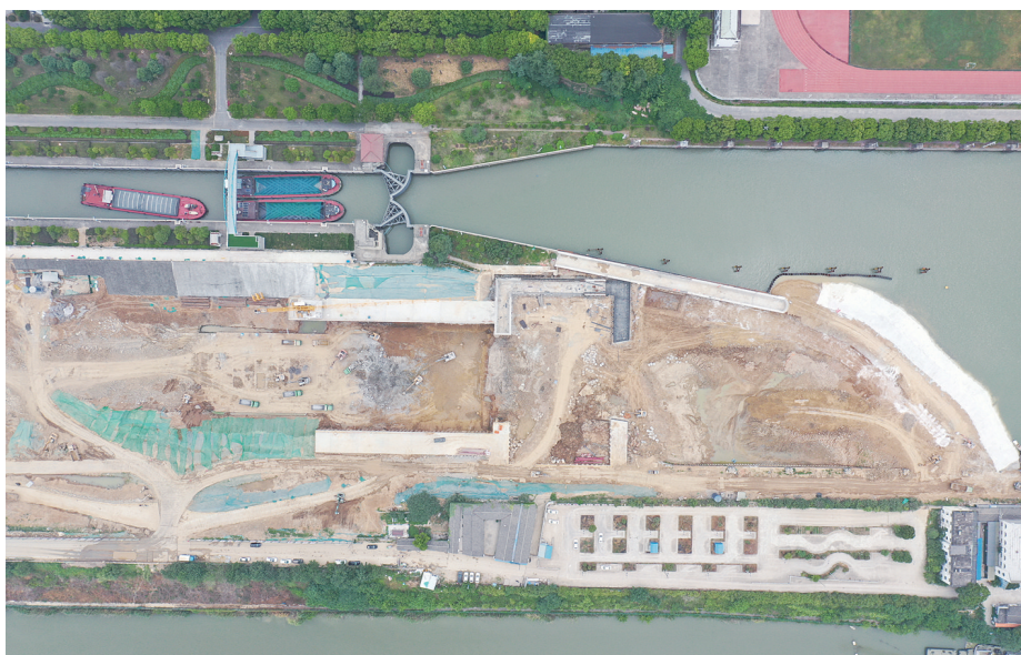
谏壁一线船闸扩容改造工程施工正酣。 周鹏 摄
