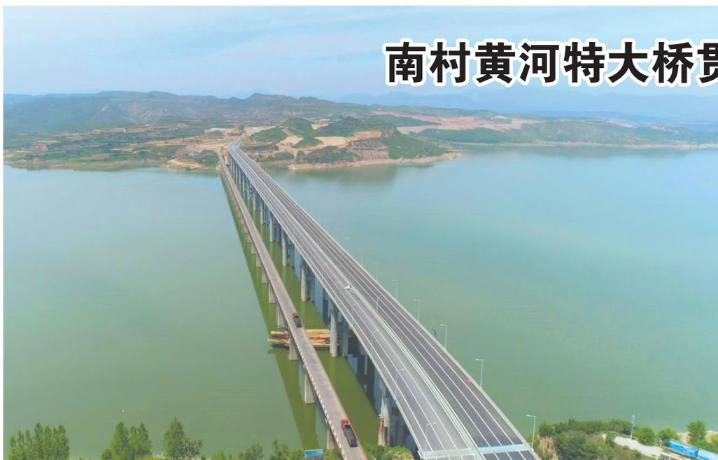
南村黄河特大桥项目地处河南、山西两省交界，是垣浞高速公路跨越黄河、连接晋豫两省的关键控制性工程。大桥全长1757米，桥宽33米，设计为双向六车道，主体结构采用多项先进工艺：基础为超大直径桩结构，下部为桩柱一体化设计，墩身设多道系梁；上部则采用一联15跨预应力混凝土刚构-连续箱梁结构，该构型在国内实属罕见。
